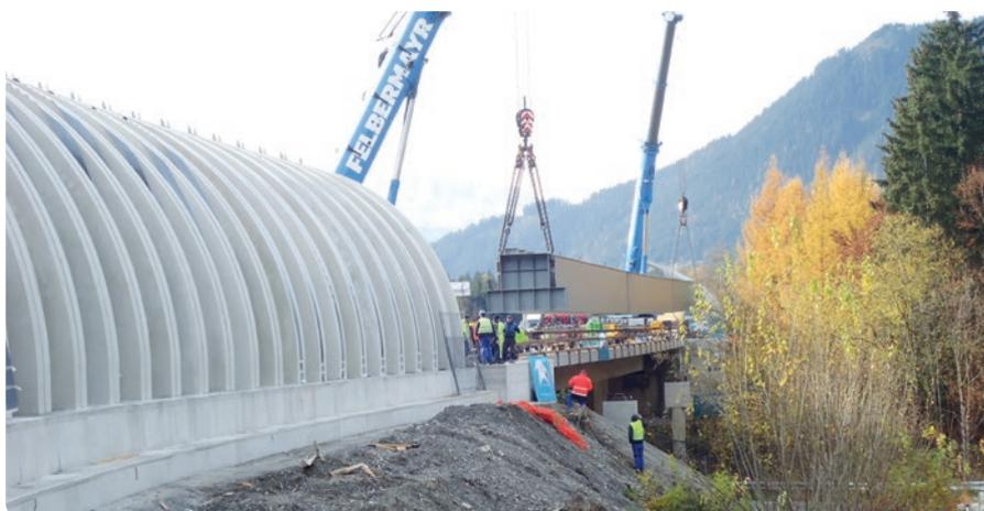
Montage des Stahlträgers für die gekrümmten Lärmschutzwände auf der Autobahnbrücke Gasthofberg am 04.11.2016. Für die Auflage dieses Trägers mussten zwei neue Brückenpfeiler errichtet werden.
