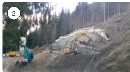
*Hangsicherung durch Spritzbeton.*
