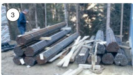
*Die sogenannten Anker für die Hangsicherung.*
