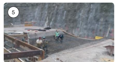
*Auf der Sauberkeitsschicht wird der Baustahlbewehrung für die Bodenplatte vorbereitet (16. April 2014).*
