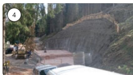
*Die Erdbewegungen, die Hangsicherung und die Planie für die Bodenplatte sind fertig (9. April 2014).*
