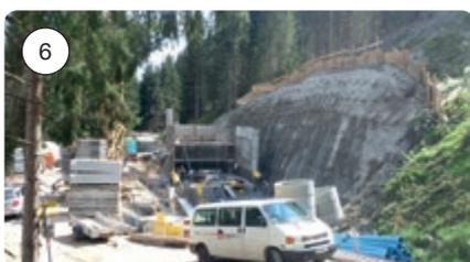
*Schalung für die erste Wasserkammer (30. April 2014).*
