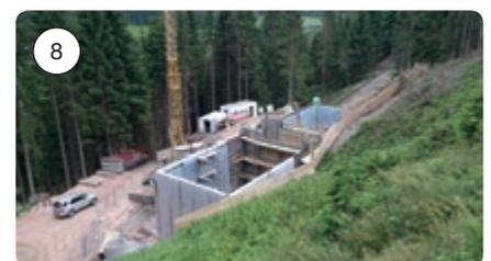
*Die Wände sind betoniert, die Schalung für die Schieberkammer ist fertig (5. Juni 2014).*
