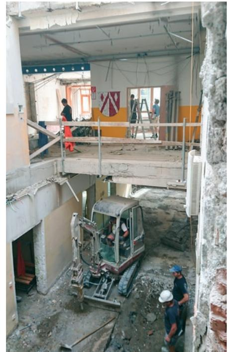
„Baufortschritt“ am 13.07.2021 im Altbestand. Das gesamte alte Stiegenhaus ist entfernt und im Untergeschoss wird gerade der Fußboden herausgeschremmt.
