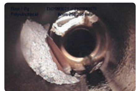
Massive Fremdwassereintritte im Abwassersystem.
