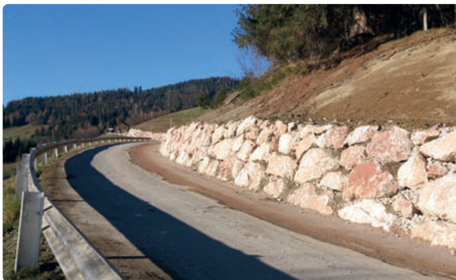
Der erste Bauabschnitt der Sanierung des Güterweges Langbruck oberhalb der Gasthofsiedlung.
