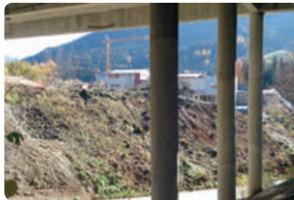
Für die neue Straße waren umfangreiche Erdbewegungen erforderlich. Das Aushubmaterial wurde großteils für die Auffüllung der alten Wegtrasse verwendet.
