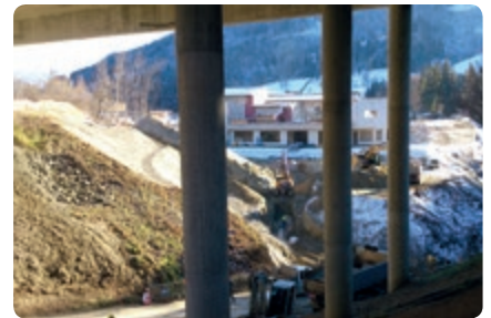
Für die neue Straße waren umfangreiche Erdbewegungen erforderlich. Das Aushubmaterial wurde großteils für die Auffüllung der alten Wegtrasse verwendet.
