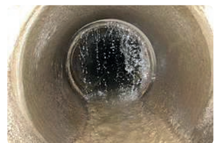
Massive Fremdwassereintritte im Abwassersystem.
