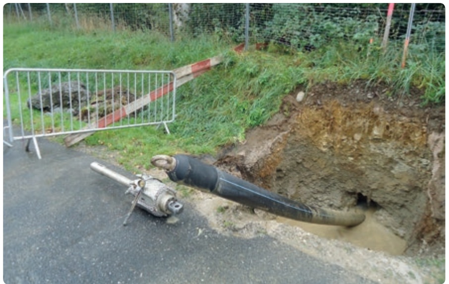
Der Spülbohrkopf und die fertig eingezogene Wasserleitung.
