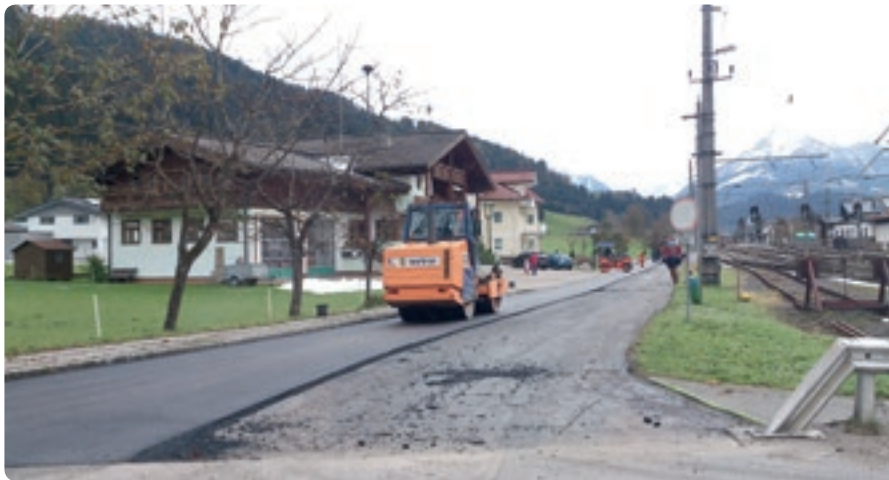
Asphaltierung der Pöttlergasse am 29.10.2014
