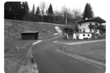
Fußgängerunterführung beim Haus Mösenbichler
