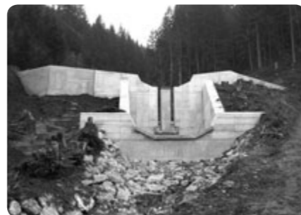
Die Geschieberückhaltesperre von der Talseite betrachtet
