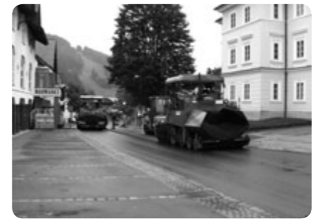
Asphaltierung der neuen Verschleißschicht
