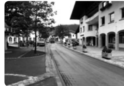
Abfräsen der alten Asphaltsschicht
