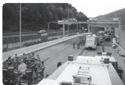
Besichtigung Einhausung Eben
