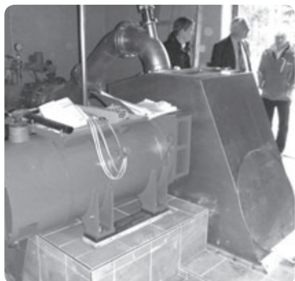
Das neue Trinkwasserkraftwerk
