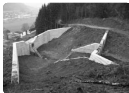
Rechts im Bild die Wildholzsperrung, unterhalb die Innenseite der Geschieberückhaltesperre
