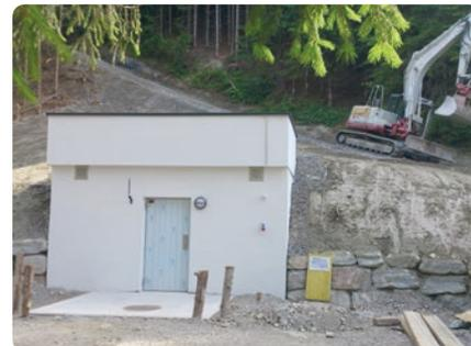
*Das Eingangsbauwerk des rundum sanierten Trinkwasser-Hochbehälters Edt, Fassungsvermögen 300m<sup>3</sup>.*
