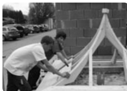
Die Arbeiten an der Kapelle für Eben schreiten voran
