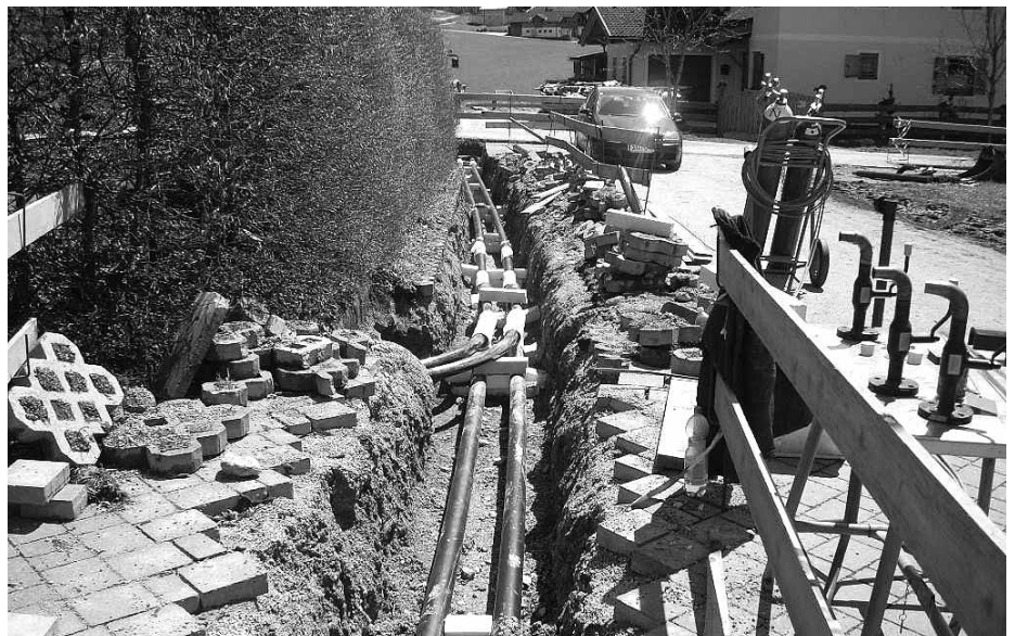
Fernwärmeleitung in der Pöttlersiedlung (Foto: Fa. Ehrenreich)
