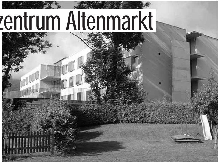
Neues Seniorenheim aus nordöstlicher Sicht vom Ortszentrum Altenmarkt aus betrachtet.
