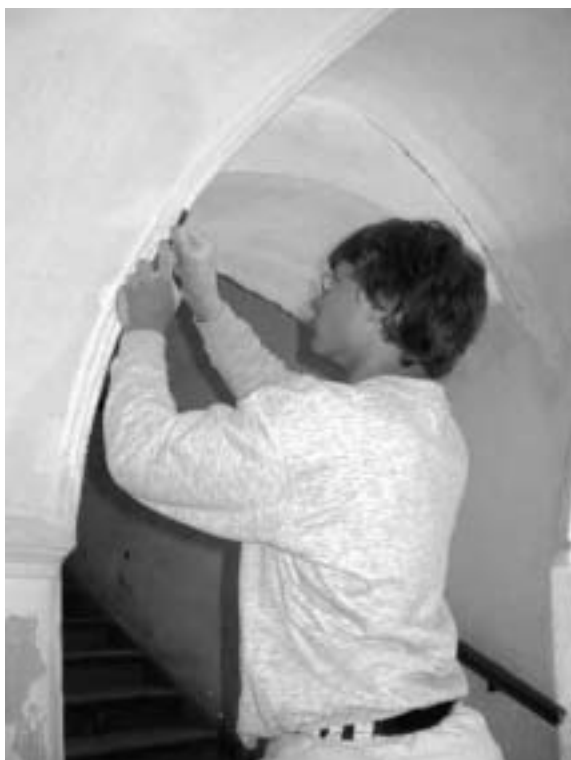
Stefan Oberlechner beim Freilegen von Stuckdetails
