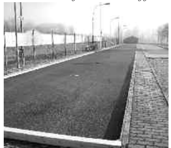
Die sanierte lange Asphaltbahn.
