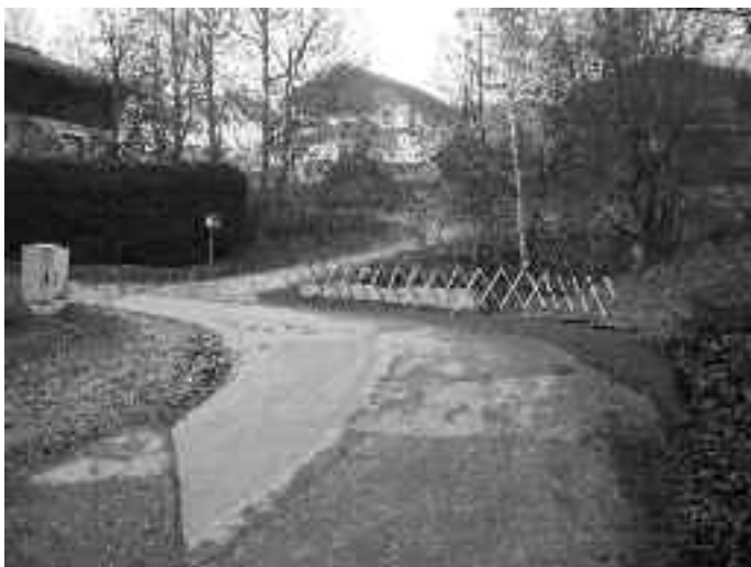
Verbreiterung der Brücke in der Gasthofsiedlung.
