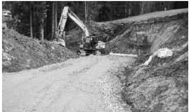
Der „Fuß“ der Trasse ist mit einem Steinsatz befestigt. Darauf wird nach und nach die wesentlich geringere Steigung von unter 12% aufgeschüttet.
