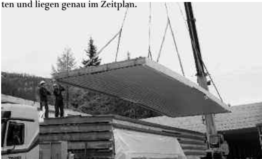
Montage der Dachelemente im November 2010 (Foto: A. Pfennich)
