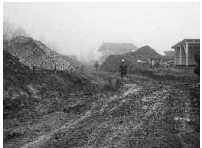
Aufschließung der Siedlung oberhalb des Dollhaus-Gutes durch die Fa. Fritz+Co. Die Verlegung und der Anschluss der Trinkwasserleitung erfolgte durch unseren Bauhof Mitarbeiter Manfred Quehenberger.
