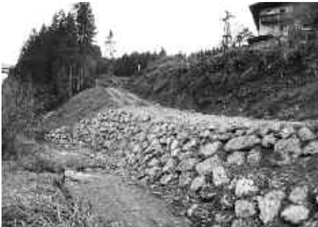
Der „Fuß“ der Trasse ist mit einem Steinsatz befestigt. Darauf wird nach und nach die wesentlich geringere Steigung von unter 12% aufgeschüttet.
