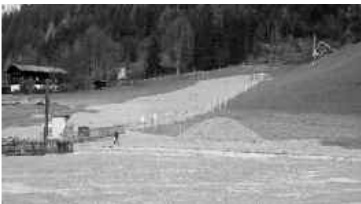
Der neue Übungslift „Topolino I“, im Vordergrund die neue Parkfläche auf dem Bundesforste-Grund. Die Baumaschinen (im Bild rechts oben) sind ausnahmsweise nicht für den Lift im Einsatz, sondern für die Verbauung des Pöttlergrabens.
